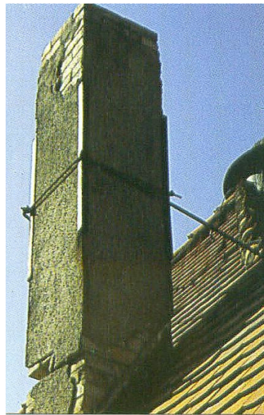
Bilder 2.3 Kamine [13], verdreht infolge Torsionsbeanspruchung, Abspannung zur Lagesicherung
